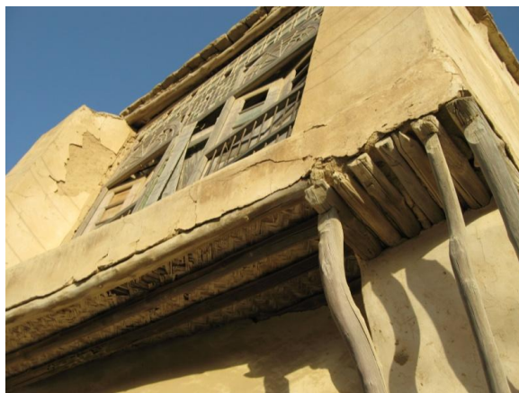
استفاده از کلپا جهت پیش کردگی ساختمان در ارتفاع
