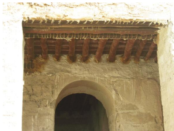
طناب پیچ کردن چندل ها جهت جلوگیری از رانش در نعل درگاه
