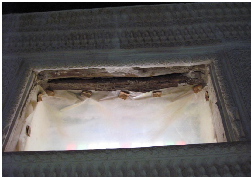
استفاده از تنه نخل شقه شده در نعل درگاه
